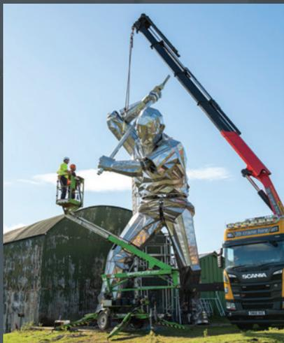
*John McKenna beim Testbau. Die Figuren wurden im Atelier in Teilen hergestellt und im Freien mithilfe von Kränen und Hebebühnen zusammgebaut.*
